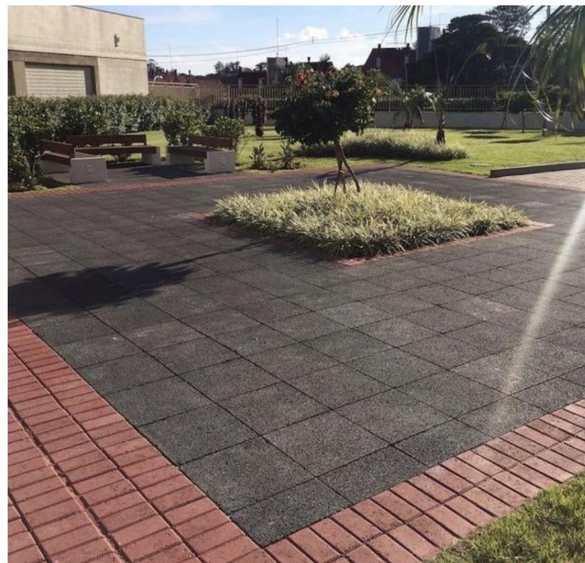
Piso drenante nas circulações para maior absorção de água de chuvas, aumentando a área permeável e melhorando a temperatura do ambiente, além de reduzir o custo de regularização, sistema de captação e grelha.
