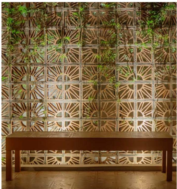
Cobogó como estratégia para ventilação, iluminação natural e isolamento em relação aos blocos que não fazem parte do complexo no entorno. Além da composição em cerâmica vermelha por meio de trabalho artesanal e sustentável.
