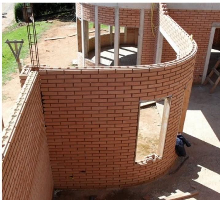
Tijolo chamado ecológico por não possuir queima em seu processo de fabricação. Também, sua utilização dispensa o uso de vigas e pilares, evitando o desperdício de madeira para as formas. Além disso, o uso em sua forma aparente, economiza reboco e pintura. Obra 100% limpa.
